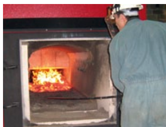
Maintenance de la chaufferie
