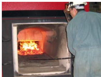
Maintenance de la chaufferie
