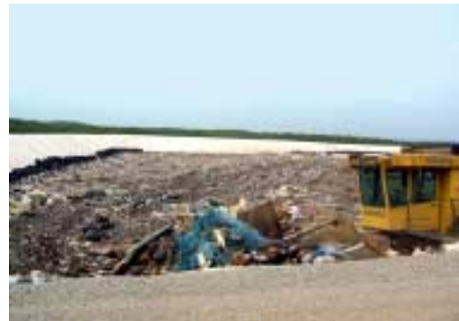
Casier du CET de Dégagnac
