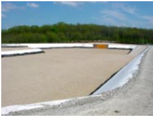
Nouveau casier du CET de Dégagnac, géotextile apparent
