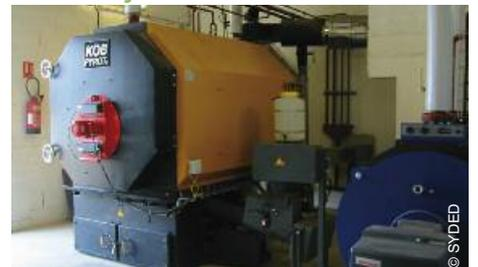
Les premiers réseaux de chaleur au bois construits et gérés par le SYDED (à Caillac et aux Quatre-Routes-du-Lot) sont opérationnels depuis le 15 octobre 2007. Le combustible utilisé est constitué de plaquettes fabriquées à partir de bois (non traité) de récupération. Le réseau de Caillac permet de chauffer une cinquantaine de bâtiments. Quant à celui des Quatre-Routes-du-Lot, il dessert 78 utilisateurs (logements et bâtiments publics).
